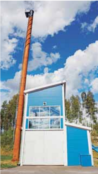
Fjärrvärmenätet i Vetil får nya kunder.
