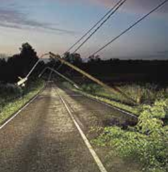
Myrskyn kaatamia sähköpylväitä Alaveteliin johtavalla tiellä.
