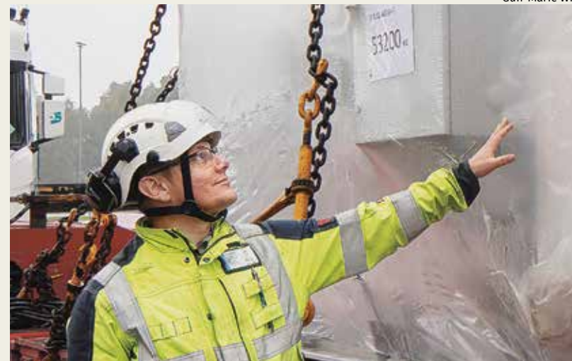
Tungt paket. 53 200 kg, läser Carl-Johan Nylund, driftchef för regionnätet och projektledare för bygget av den nya elstationen. Med oljor och annat på plats i transformatorn stiger vikten till över 58 ton.
