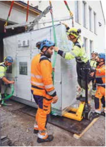
Sähkökattilan kojeiston asennus.
