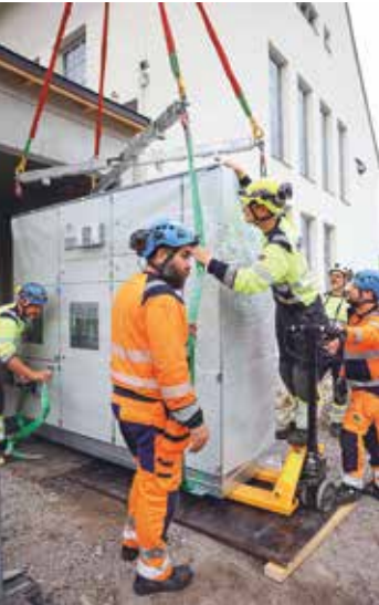
Installering av det ställverk som ska mata pannan med el.
